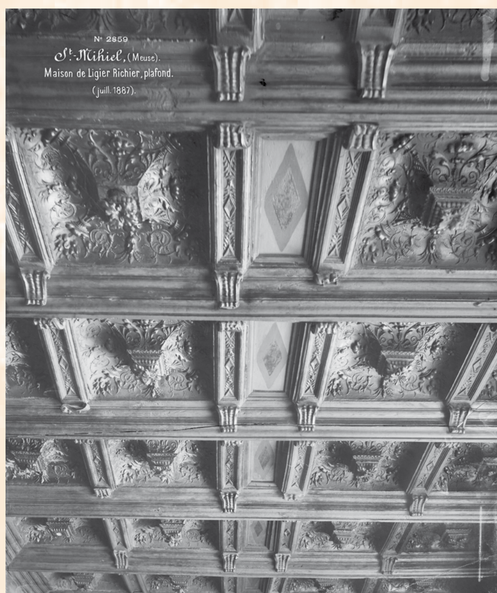
Photographie de Médéric Mieusement réalisée en 1887 au titre de la Commission des Monuments Historiques : Plafond à caissons de la Maison de Ligier Richier à Saint-Mihiel.
