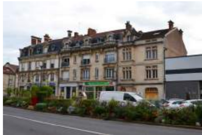
Place Jacques Bailleux Photographie : A. Husson architecte
