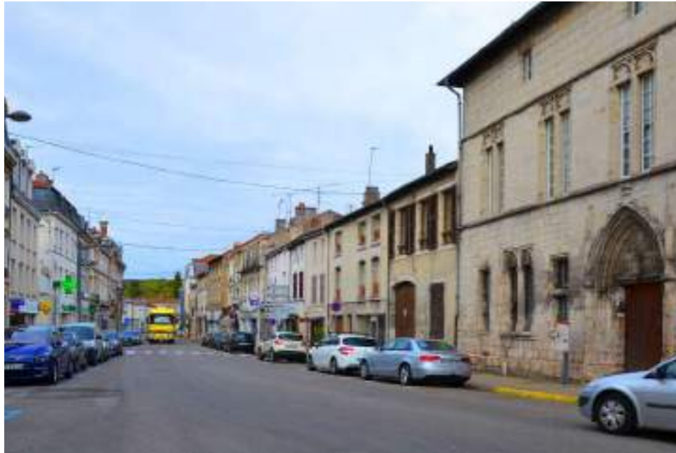
Axe structurant nord-sud, la rue du Général Pershing. Photographie : A. Husson architecte
