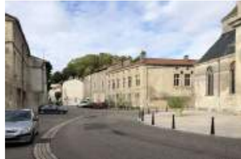
Place devant l'église Saint-Etienne Photographie : A. Husson architecte
