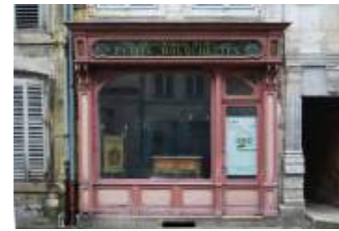
Rue Raymond Poincaré Photographie : A. Husson architecte
