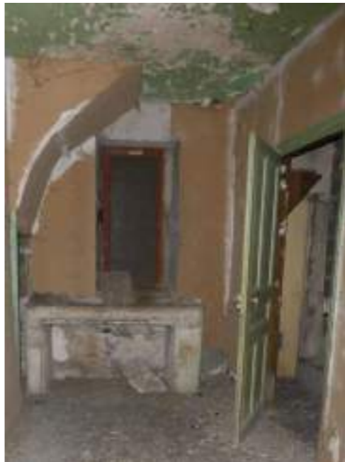
5 rue du général Audéoud Photographie : A. Husson architecte, 2020
