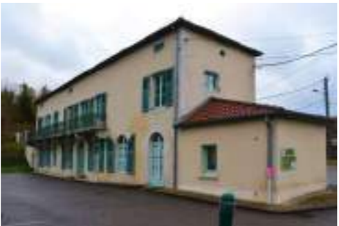
Maison médicale Photographie : A. Husson architecte
