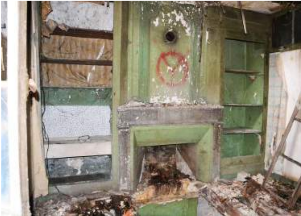
1 rue des tisserands Photographie : A. Husson architecte, 2020
