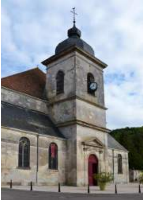
Eglise Saint-Etienne Photographie : A. Husson architecte
