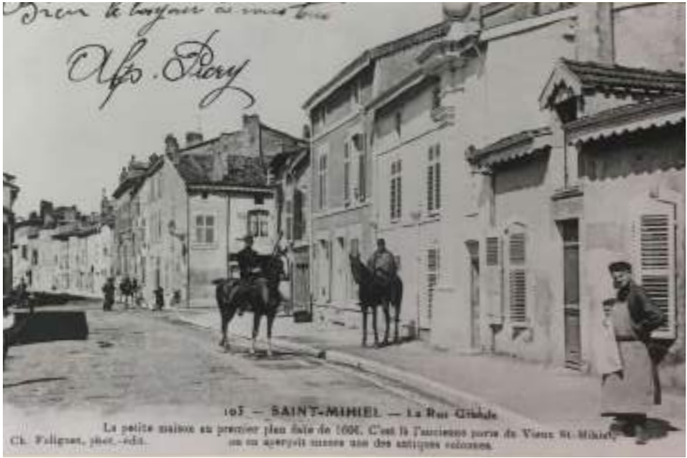
Vestiges d'une ancienne porte d'entrée des fortifications Source : Service Régional de l'Inventaire
