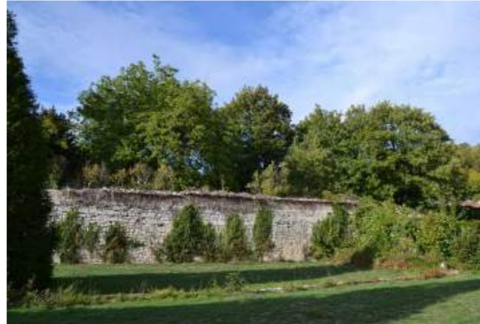
Ancien mur de fortifications présent dans le Bourg. Photographie : A. Husson
