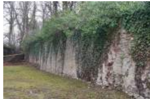
Vestiges de fortifications longeant le site. Photographie : Commune de Saint-Mihiel
