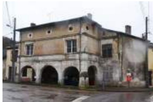
Immeuble dit « Café des Arcades », inscrit M.H./ Photographie : A. Husson architecte
