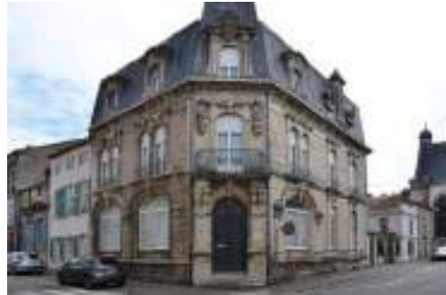
Ancienne caisse d'épargne; Photographie : A. Husson architecte
