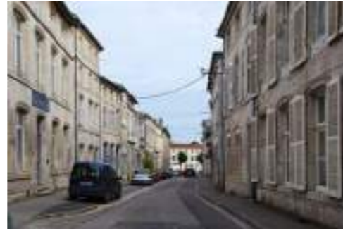
Rue Raymond Poincaré Photographie : A. Husson architecte
