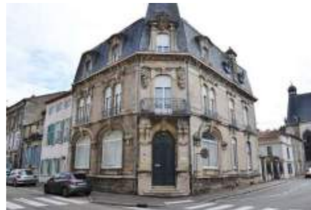
Ancienne caisse d'épargne Photographie : Commune de Saint-Mihiel
