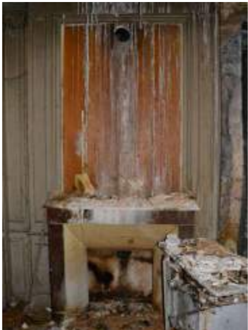
1 rue des tisserands Photographie : A. Husson architecte, 2020
