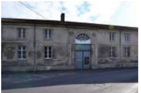
Anciens abbatoirs rue du Dr Albert Thiery Photographie : A. Husson architecte
