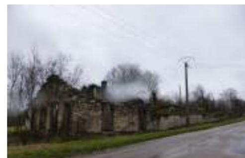
Photographies actuelles des casernes Négrier. UDAP 55
