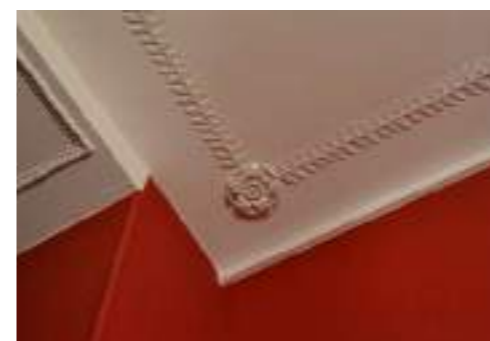
Moulures 2 rue des Chanoine Photographie : A. Husson architecte, 2020
