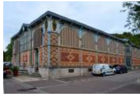
Marché couvert Photographie : A. Husson architecte
