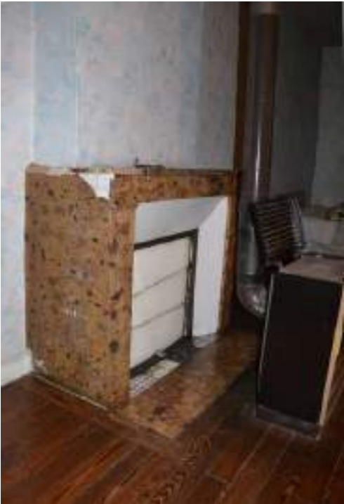
17 rue des écoles Photographie : A. Husson architecte, 2020
