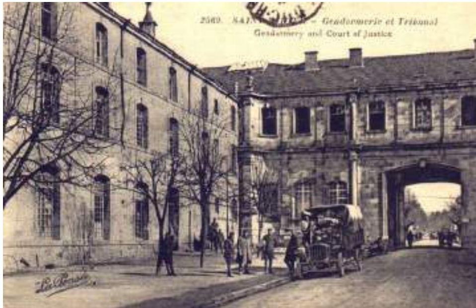
Percement de l'aile orientale et intégration de la gendarmerie dans l'édifice Source : Commune de Saint-Mihiel
