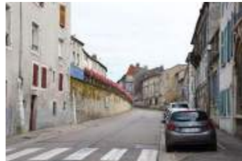
Rue Carnot Photographie : A. Husson architecte
