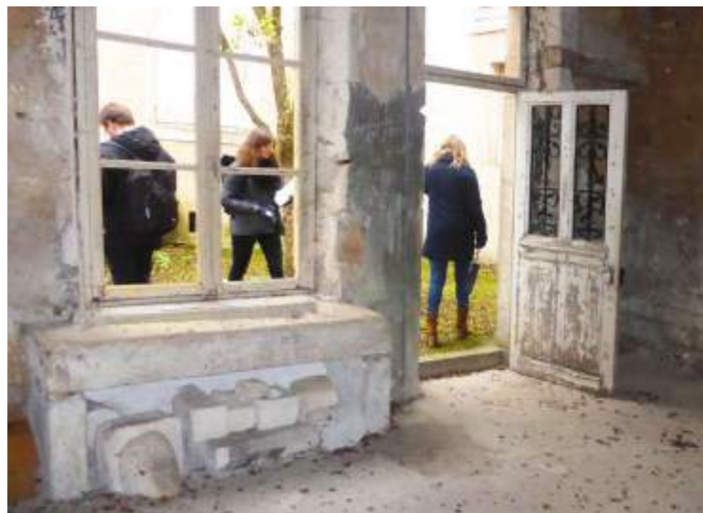
29 rue Raymond Poincaré Photographie : A. Husson architecte, 2020
