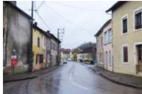
Rue Porte à Nancy Photographie : A. Husson architecte
