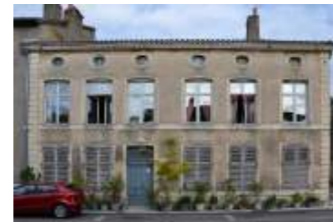
Rue du Général Audéoud Photographie : A. Husson architecte
