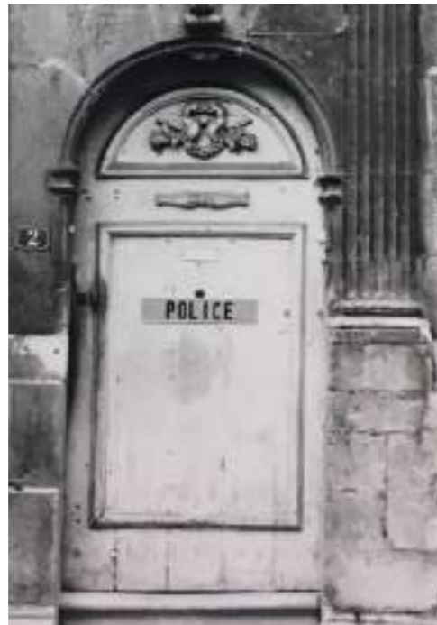
élévation antérieure, porte piétonne 2 rue Raymond Poincaré, sélectionné Photographie : SRI, 1975
