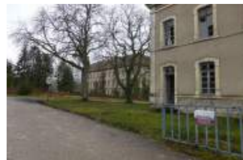
Photographies actuelles des casernes Sénarmont. UDAP 55
