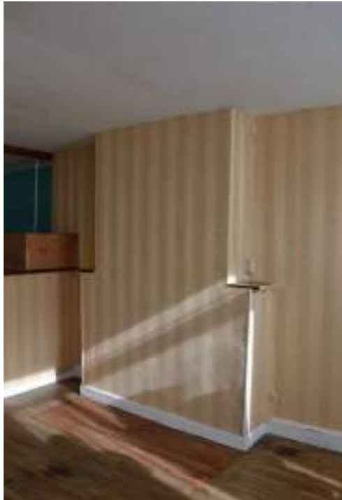
18 rue Carnot Photographie : A. Husson architecte, 2020
