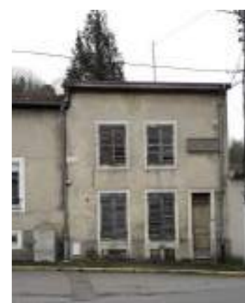
Ancien octroi Photographie : A. Husson architecte
