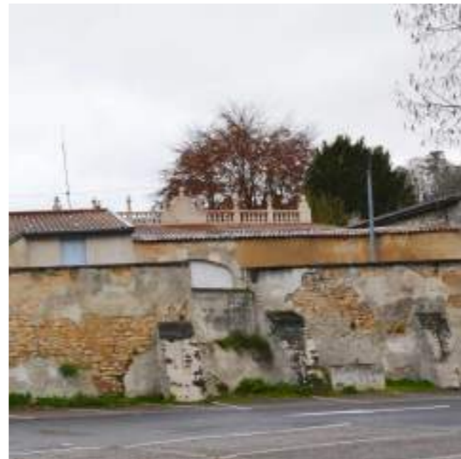
Vestiges d'ancien mur de fortification de l'abbaye (quartier de l'abbaye) Photographie : A. Husson architecte
