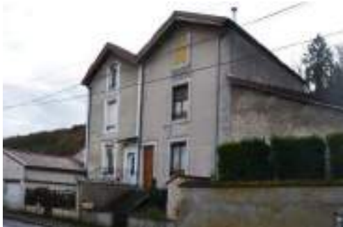
Maison rue des Abasseaux Photographie : A. Husson architecte
