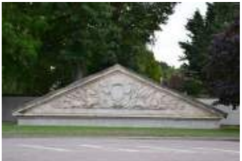
Place du Quartier / fronton Photographie : A. Husson architecte
