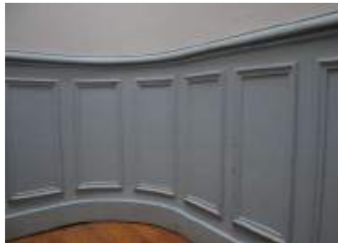
Boiseries 25, rue Carnot Photographie : A. Husson architecte, 2020
