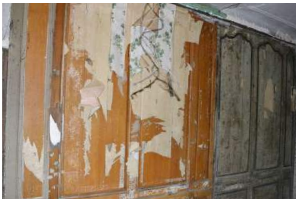
1 rue des tisserands Photographie : A. Husson architecte, 2020
