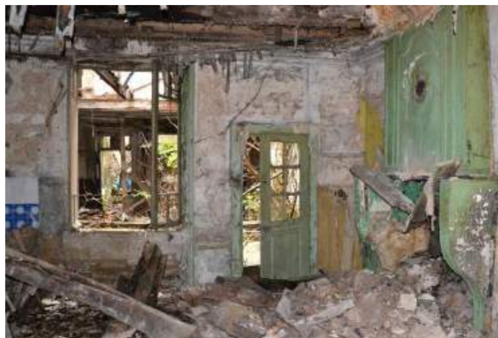
1 rue des tisserands Photographie : A. Husson architecte, 2020
