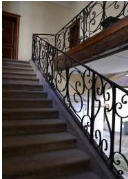
18 rue Carnot Photographie : A. Husson architecte, 2020
