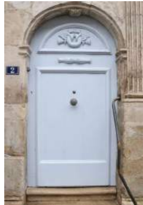
élévation antérieure, porte piétonne 2 rue Raymond Poincaré, sélectionné Photographie : A. Husson architecte, 2020
