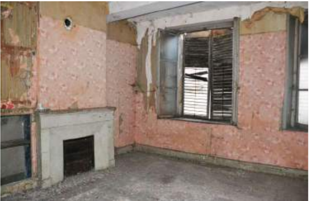
5 rue du général Audéoud Photographie : A. Husson architecte, 2020
