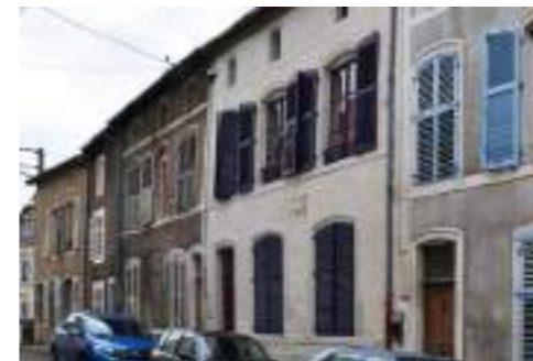
Maison Ligier Richier, classé M.H Photographie : A. Husson architecte
