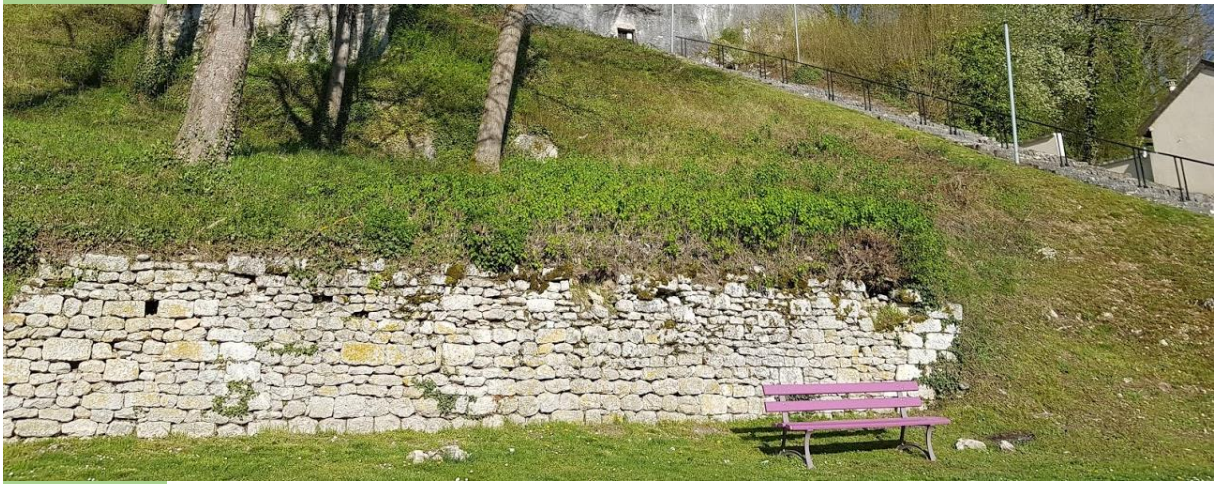
Le mur avant travaux (avril 2019)
