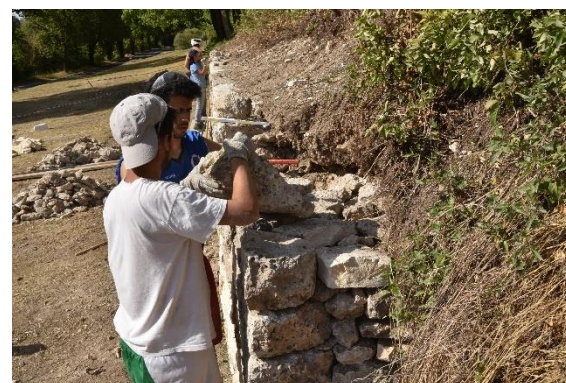
Pose des pierres
