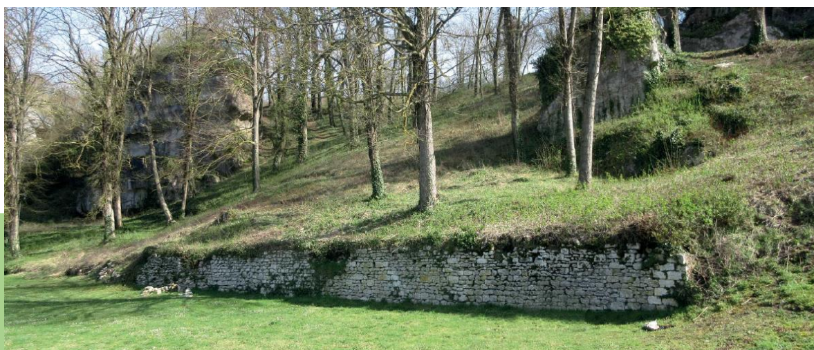
Le mur avant restauration (avril 2019)
