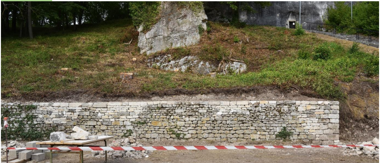
Le mur après travaux (août 2019)
