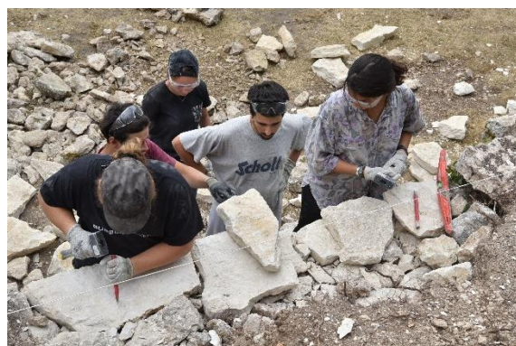
Pose des pierres
