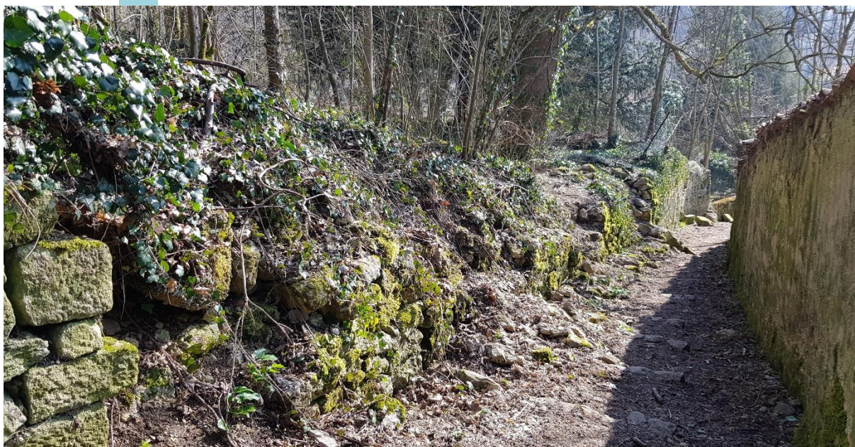
État du mur avant restauration (mars 2021)
