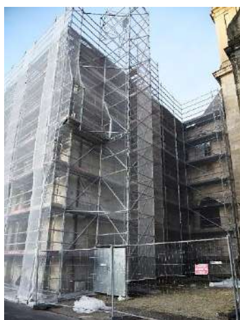
Pendant la restauration
