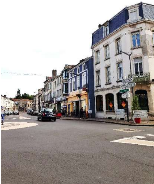
Réfection de la D964 en 2018 par l'Agence départementale d'Aménagement (Meuse)
