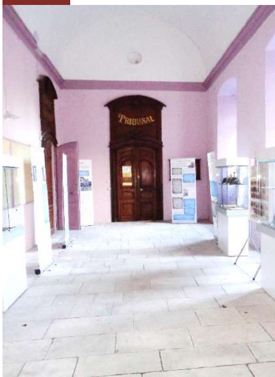
La salle des pas perdus avant restauration
