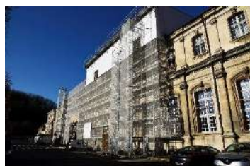
Pendant la restauration
