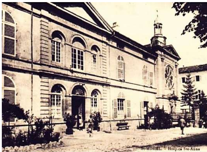
Vue de l'entrée de l'ancien hospice Sainte-Anne (XX e siècle)
