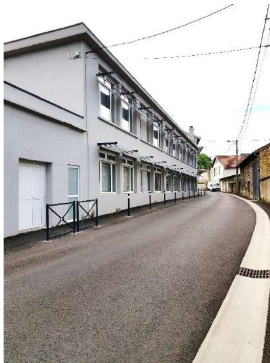
Réfection de la rue Morguesson en 2018 par la Codecom du Sammiellois
