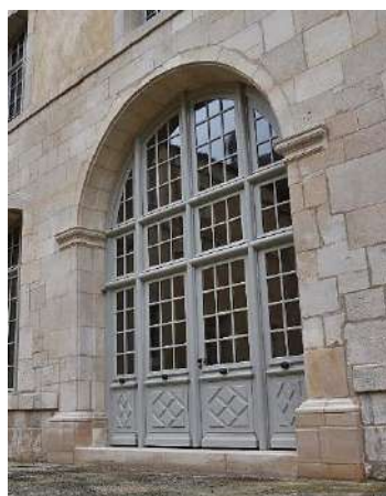
Menuiserie après restauration
