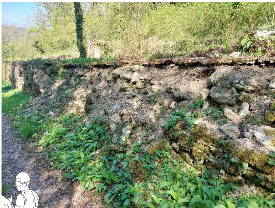
Le mur de soutènement avant restauration (© Ville de Saint-Mihiel, 2025)
